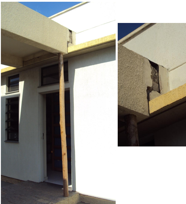
No detalhe, solução improvisada representa perigo
